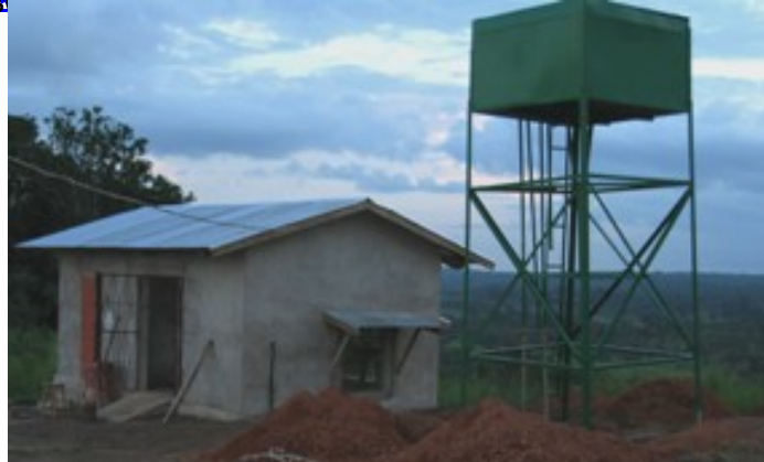
Blick auf die Wasserleitung 2010
